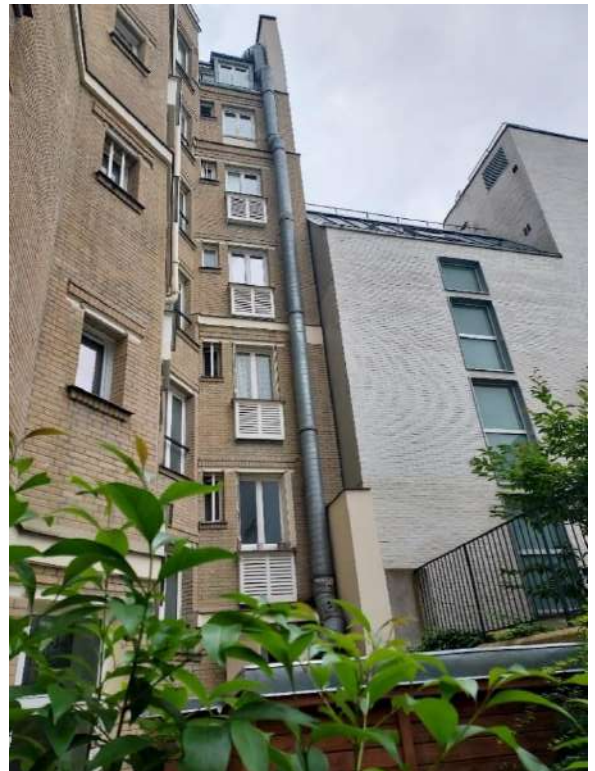
Photo n°13 (cour intérieure de la parcelle AV 26)
