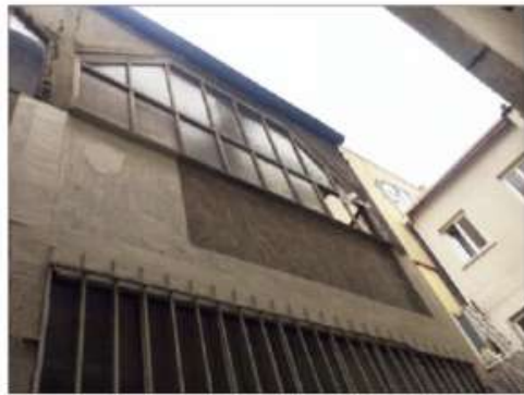
Photos extérieur des châssis types Atelier
